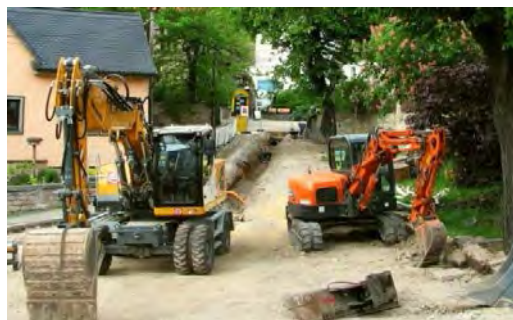
Am 17. Dezember 2015 erfolgte die Abnahme des fertiggestellten 2. Bauabschnittes
