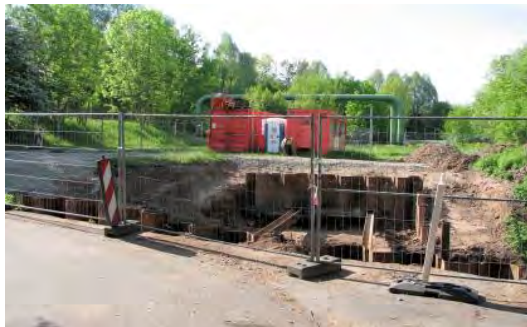
Überbrückung des Abwasserkanals (Mai 2015)
