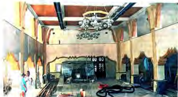
Der denkmalgeschützte Saal ist derzeit eine Baustelle. Der Schwingboden in der Saalmitte soll erhalten bleiben. Unter den Emporen soll der Fußboden erneuert werden.
