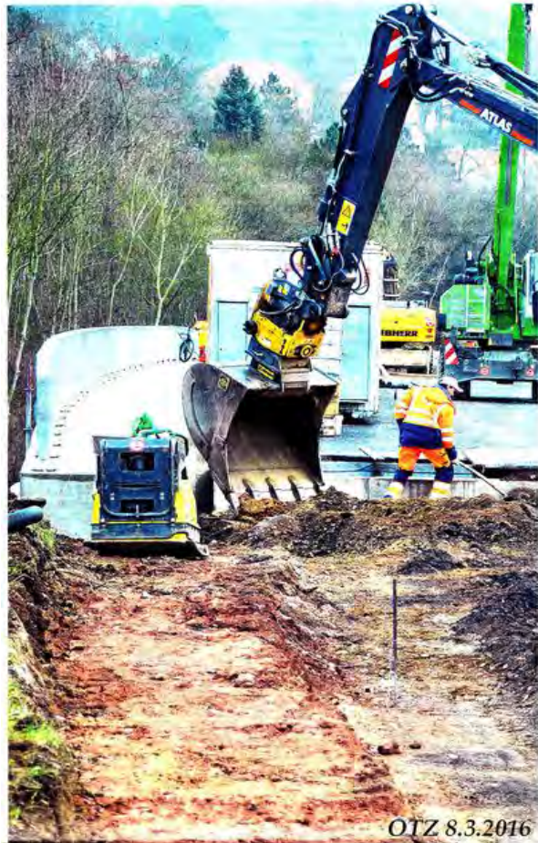
Brücke bei Lobeda bald fertig
