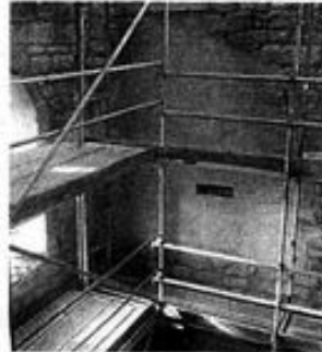
Der längliche Mauerschlitze ist eine speziell für die kleinen Hufeisennasen geschaffene Einflugöffnung.
