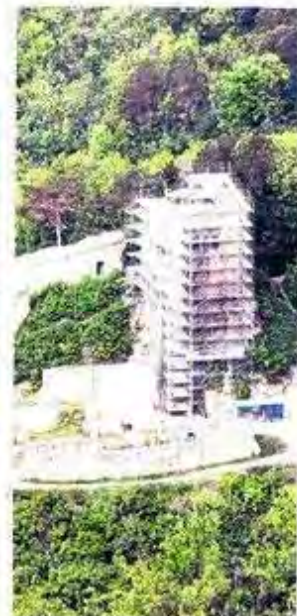
Blick auf die Lobdeburg bei Jena, die derzeit saniert wird.
