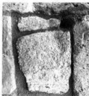
Eine Bruthöhle wurde vor der Sanierung mit einem Holzklötzchen markiert; rechts im Bild die Höhle inmitten neuer Fugen.
