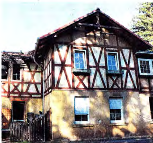
Der Morgen danach: Dieses Fachwerkhaus ist am Samstagabend in Lobeda-Altstadt komplett ausgebrannt. Die Löscharbeiten dauerten bis in die Morgenstunden am Sonntag an. FOTO: KATJA DÖRN
