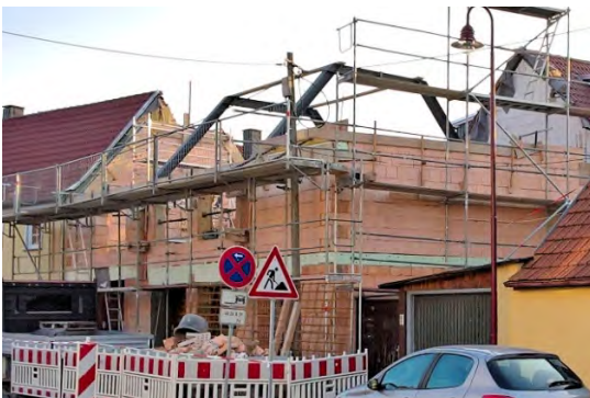
Aufsetzen der Dachträger (31.10.2019)
