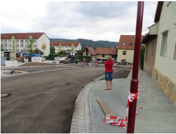
Aufbringung der Deckschicht 8. - 13. Juli 2019, Foto Uwe Bogdanski
