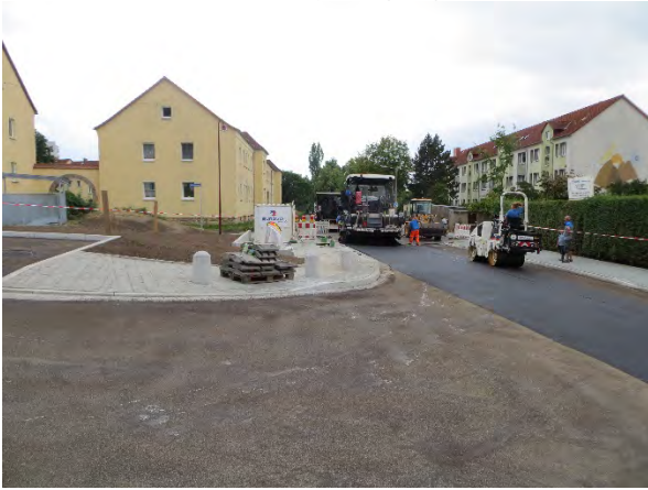
Aufbringung der Deckschicht 8. - 13. Juli 2019, Foto Uwe Bogdanski
