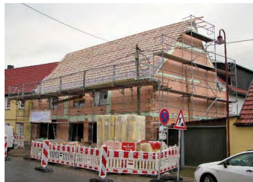
Rohbau fertig für das Richtfest (08.11.2019)
