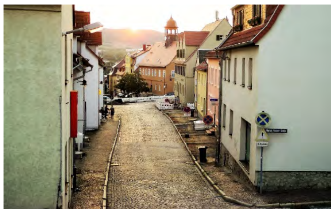
Beginn der Baumaßnahmen am 27. August 2019, Foto Sigurt „Max“ Horn
