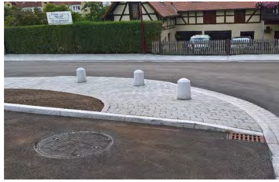
Der Kanalschacht ermöglicht Zugang zum Gewölbekeller
