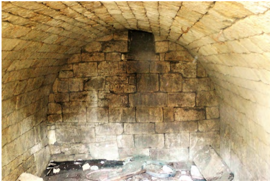
Freigelegter Gewölbekeller unter der ehemaligen Thurms Scheune, Foto Sigurt „Max“ Horn
