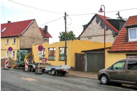
Abriss der Tischlerei im August 2019
