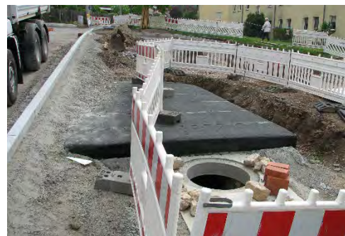
Abdeckung des Gewölbekellers mit einer Betonplatte und Einbau eines Kanalschachtes
