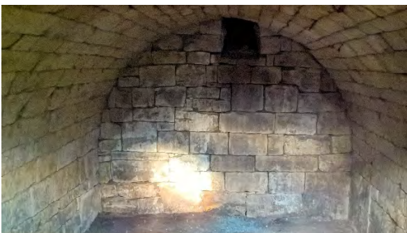
Innenansicht des Gewölbekellers
