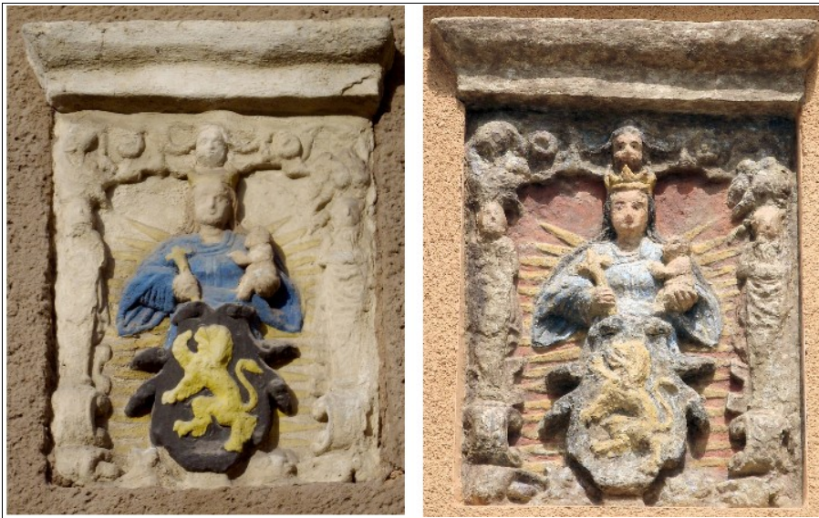
Abb. 4: Das Wappen am Lobedaer Rathaus vor und nach der Sanierung (rechts), Foto: W. Marckwardt 2016
