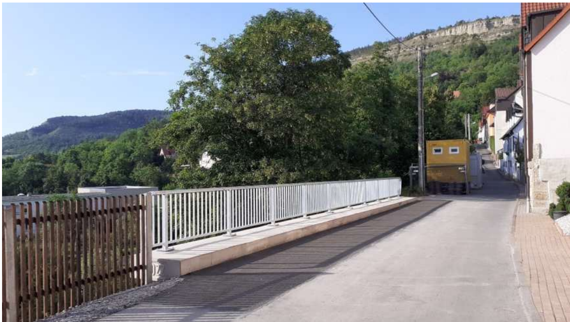
Die Hangabsicherung der Klara-Griefahn-Straße wurde am 30. Juni 2022 abgeschlossen
