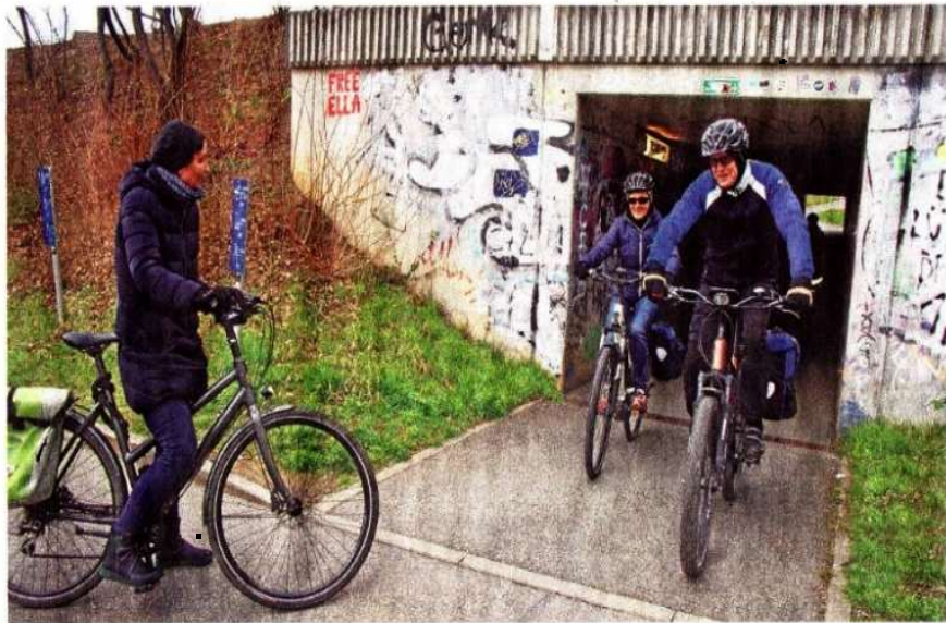
Ohne gegenseitige Rücksichtnahme geht hier gar nichts: Auf seiner Westseite trifft der schmale Goldbergtunnel rechtwinklig auf den Hauptadweg Stadtzentrum - Lobeda-West. 45 Meter lang ist der Durchlass. FOTO: THOMAS BEIER
