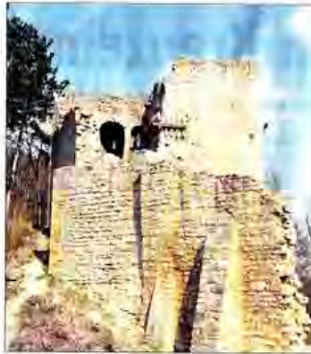
Die Ruine der Lobdeburg liegt auf einem Felsvorsprung zwischen den Fluren von Lobeda und Drackendorf.
